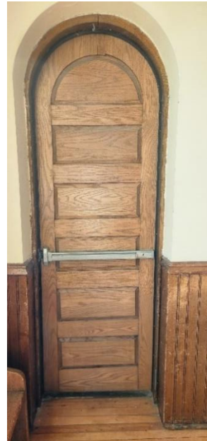
FIG. Div.8. 25 – East Fire Escape Exit Door
