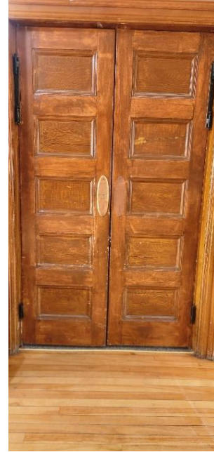
FIG. Div.8. 19 – Auditorium Doors
