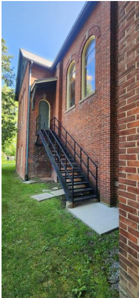
FIG. Div.5. 4– West Fire Escape
