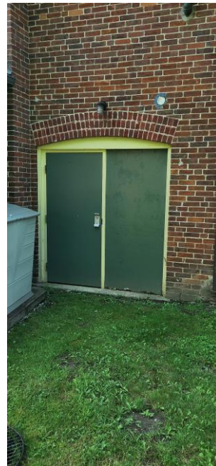
FIG. Div.8. 8– Rear Exit Door 1
