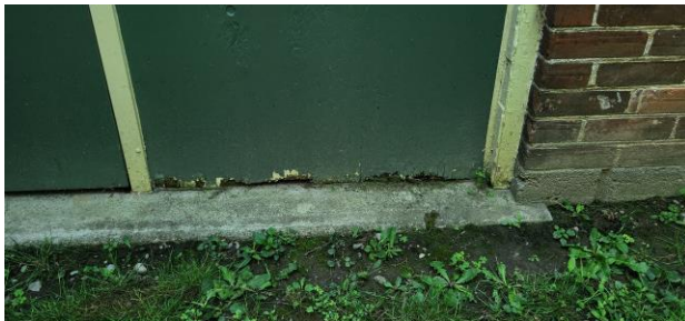
FIG. Div.8. 9– Rear Exit Door 2
